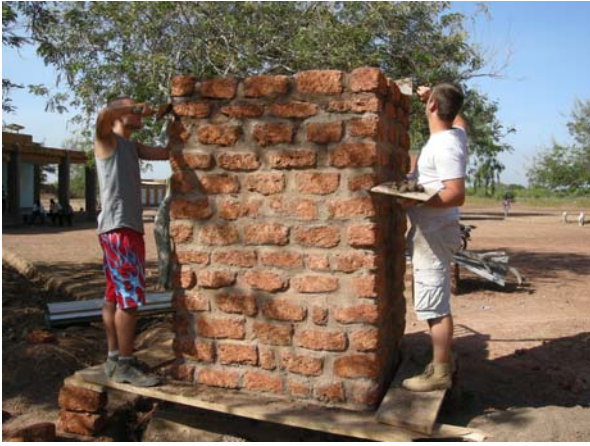
Construction d'un abri fermé pour le compteur
