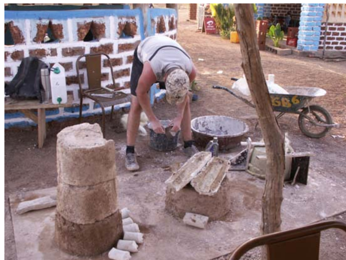
construction des parois
