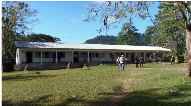
Le bâtiment scolaire rénové en 2016
