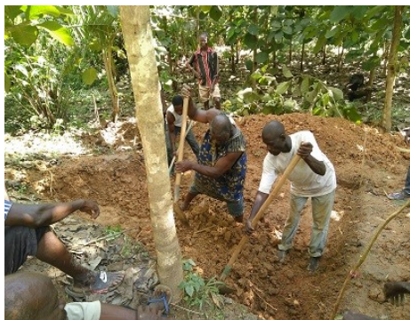
Terrassements du dépotoir assuré par les bénéficiaires (contribution)
