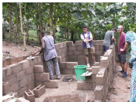
Construction des murs en maçonnerie du dépotoir
