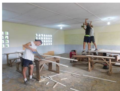
Rabotage, peinture et fixation des cimaises et des « baguettes »
