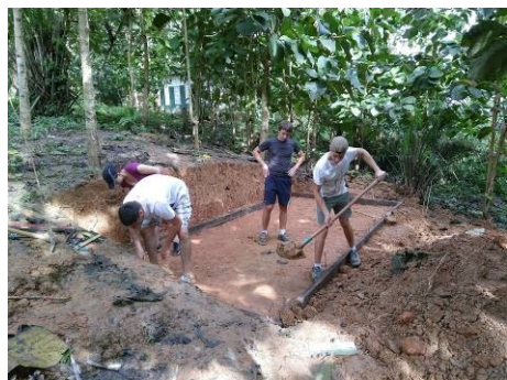
Coffrage / ferrailage / bétonnage du radier du dépotoir
